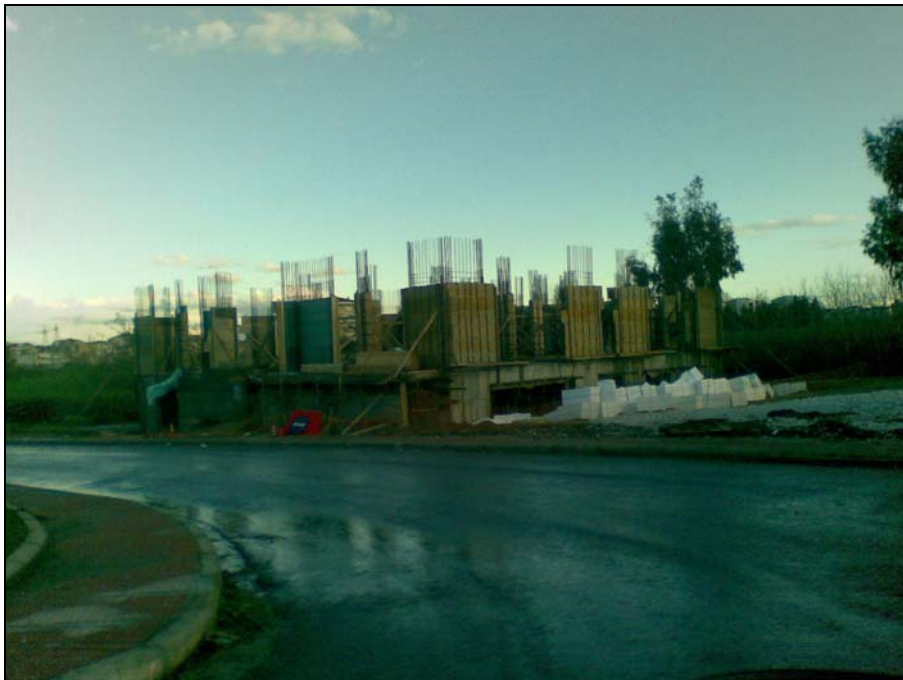
Το υπο-ανέγερση νέο κτήριο του Τμήματος
